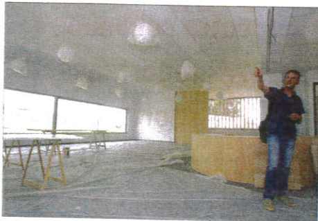
La future médiathèque: comptoir d'accueil posé, lustres installés.
