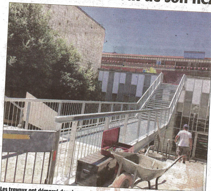
Les travaux ont démarré depuis une semaine.
