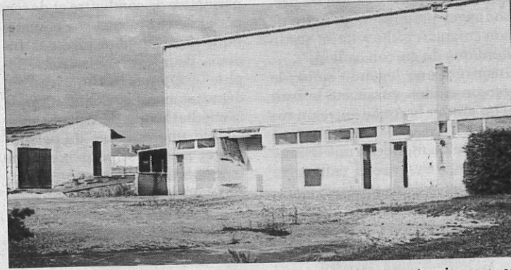
La maison du gardien a été démolie et les travaux de désamiantage entrepris. Photo CL
