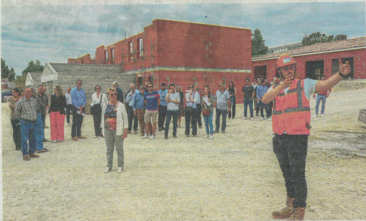
Une visite de chantier des 45 futurs logements a eu lieu jeudi au quartier du Treuil, à Gond-Pontouvre. Julie Desbois
